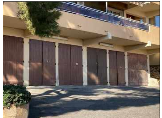
Vue sur les garages
