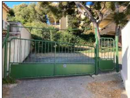
Portail d'accès au bâtiment des garages
