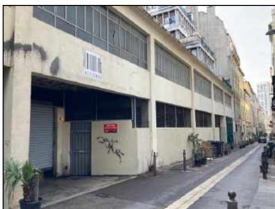
Rue Thubaneau – accès Rdc
